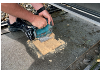
1.9 Dachöffnungsgröße 20/20 cm. Holzfaser hat keine erkennbaren Verfärbungen und keine sensorischen Auffälligkeiten (angenehmer Holzgeruch).
