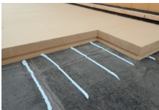
1.1 Dampfsperre mechanisch befestigt, Nähte verschweißt, als Behelfsabdichtung auf Holzwerkstoffplatte OSB. Gefälle konstruktiv vorhanden.
