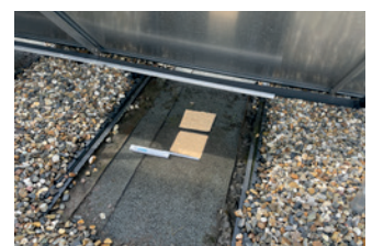
1.8 Dachöffnung im Juni 2023: Im bauphysikalisch ungünstigsten Bereich (bekiest und verschattet) wurde eine Kontrollöffnung des Dachsystems vorgenommen.
