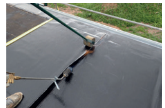
1.4 Verlegen der ersten Abdichtungslage. Kaltselbstklebende Bitumenbahn SOPRALENE Stick 30 Duo mit Sicherheitsnaht.
