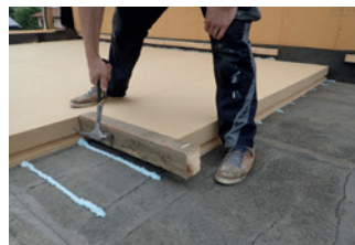
1.2 PAVATEX Holzfaserdämmplatte ISOLAIR ECO verlegt in Dämmstoffklebschaum. Anzahl der Klebstoffraupen nach Windsogberechnung.
