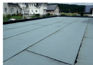
1.7 Nach mehrtägiger Arbeitsunterbrechung erfolgt die Verlegung der wurzelfesten Oberlagsbahn.
