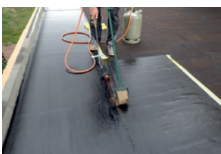
1.5 Die Sicherheitsnähte werden mit Brenner und Andrückrolle verschweißt. Erste Lage erfüllt so die Funktion der Behelfsabdichtung.
