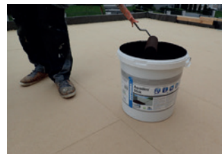
1.3 Grundierung der Holzfaserdämmung mit lösemittelfreiem Bitumenanstrich AQUADERE Stick.
