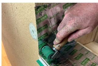
**1.5** PAVATAPE mind. 150 mm an der Leibung hochführen und faltenfrei sowie vollflächig andrücken – idealerweise mit Andrückrolle oder Rakel – für eine dauerhaft sichere und schlagregendichte Abdichtung.
