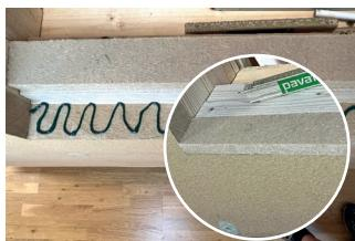
**1.1** Der Auftrag des systemzugehörigen Klebers PAVACOLL wird schlängelförmig auf die vorbereitete Klebefläche aufgebracht. Anschließend wird der Unterfensterbankkeil passgenau eingelegt und durch gleichmäßigen Anpressdruck fixiert.
