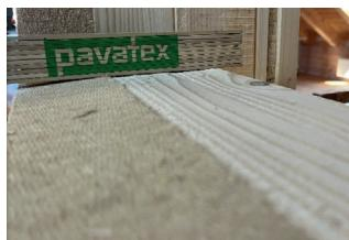
**1.2** Der Unterfensterbankkeil wird bündig zum Aufstellholz eingebaut und erhält ein Gefälle von 5° (= 8 %) nach außen. Dieses Gefälle ist entscheidend für den kontrollierten Wasserablauf und für einen dauerhaft schlagregendichten Fensteranschluss.
