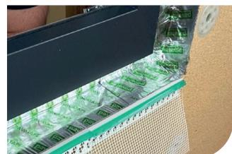
**2.9 Nach dem faltenfreien Verkleben wird der überstehende Rand des PAVATEX sauber zurückgeschnitten, ohne dabei die Verklebung oder Klebeflächen zu beschädigen.**
