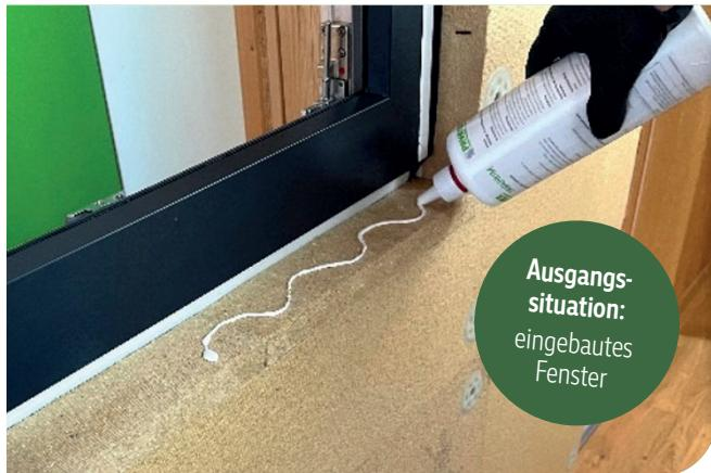
**Die zweite Dichtebene bildet ein zentrales Element für einen bauphysikalisch sicheren und schlagregendichten Fensteranschluss.**
