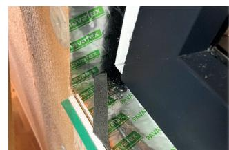
**1.7** PAVATEX Fugendichtband (ca. 15 cm) zuschneiden und schräg aus der Ecke zur Brüstungsvorderkante aufkleben. Feuchtigkeit läuft so zwingend über das Tropfkantenprofil ab.
