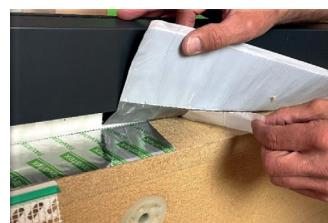
**2.1 Den sauberen und trockenen Unterfensterbankkeil aus Holzfaserdämmstoff gleichmäßig mit PAVAPRIM grundieren und gemäß Herstellerangaben trocknen lassen.**
