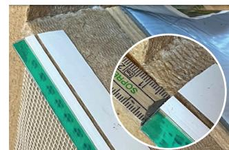
**1.3** Zur sauberen und sicheren Ausbildung des Putzabschlusses wird das Tropfkantenprofil an der Vorderkante des Unterfensterbankkeils angebracht. Den Systemkleber PAVACOLL gleichmäßig auftragen. Das Profil ausrichten, ca. 15 mm Abstand zur Leibung einhalten und mit leichten Anpressdruck fixieren.
