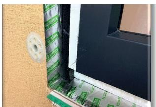
**1.6** Das Fenster fachgerecht einbauen. Die Abdichtung zur Leibung muss luft- und schlagregendicht sein. Für die Anschlüsse eignet sich das vorkomprimierte Fugendichtband PAVACASA (BG1 nach DIN 18542).
