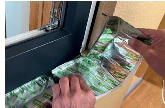
**2.5 Die Dichtecke wird so vorbereitet, dass sie spannungsfrei und passgenau in der Innenecke verarbeitet werden kann. Dafür im Eckbereich den Liner dreieckig entfernen und zusätzlich entlang der Kante ca. 20 mm vom Rand entfernen einritzen. So lässt sich der Schenkel später sauber an die Leibung (mind. 150 mm hoch) verkleben.**
