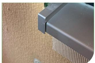
**1.8** Beim Einbau der Fensterbank sind seitlicher Überstand und saubere Leibungseinbindung zu beachten. Die Befestigung erfolgt durch Schrauben, Einklicken oder Verkleben. Anchlussfugen sind dauerhaft schlagregendicht mit Fugendichtband (z. B. PAVACASA) abzudichten.
