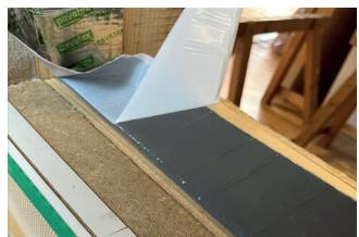
**1.4** Zur sicheren Abdichtung wird das PAVATAPE wattenförmig über den Unterfensterbankkeil, das Aufstellholz und in die seitlichen Leibungen verklebt. Zuvor ist die Holzfaserfläche mit PAVAPRIM zu grundieren – gleichmäßig auf sauberen, trockenen Untergrund auftragen und gemäß Herstellerangabe trocknen lassen.
